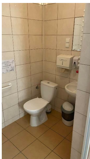
Zdjęcie nr 16: Toaleta
