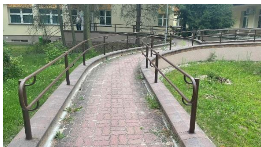
Zdjęcie nr 4: Pochylnia zewnętrzna
