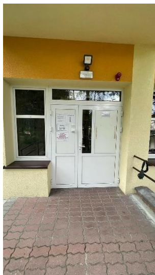
Zdjęcie nr 5: Wejście do budynku
