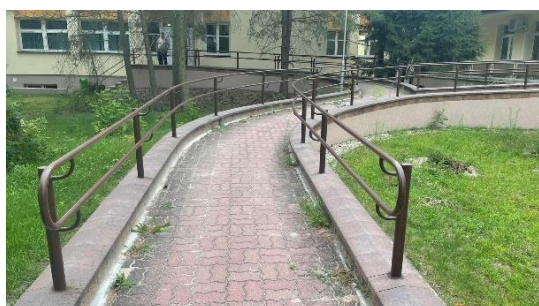
Zdjęcie nr 4: Pochylnia zewnętrzna
